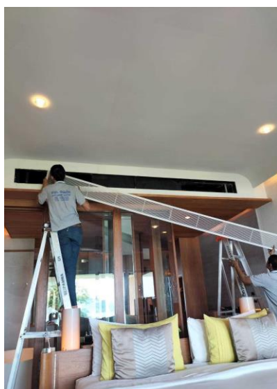
รูปภาพที่ 2.2 การทำความสะอาดเครื่องปรับอากาศ
