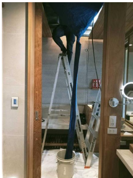
รูปภาพที่ 2.29 การทำความสะอาดเครื่องปรับอากาศ
